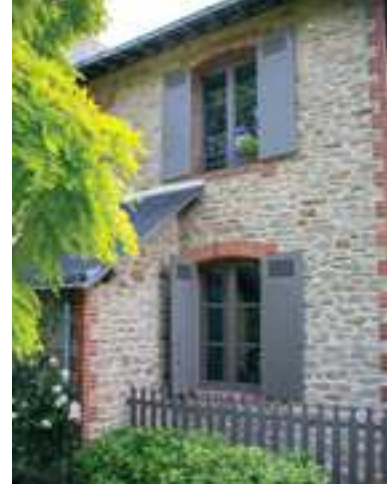
Finition des volets réalisée par le client
