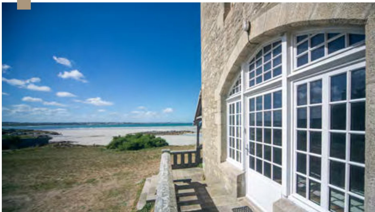
Renovation de l'ancien avec petits bois collés et imposte fixe
