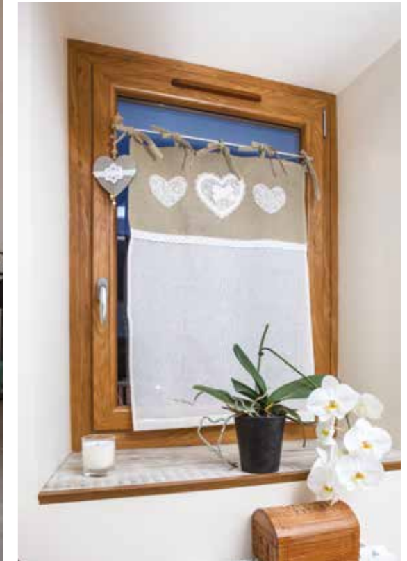
Fenêtre oscillo-battante posée en embrasure. Option ferrage invisible pour limiter l'ouverture pour ces cas de pose.
