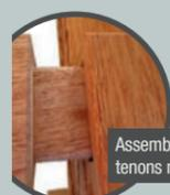
Assemblage tenons mortaises
